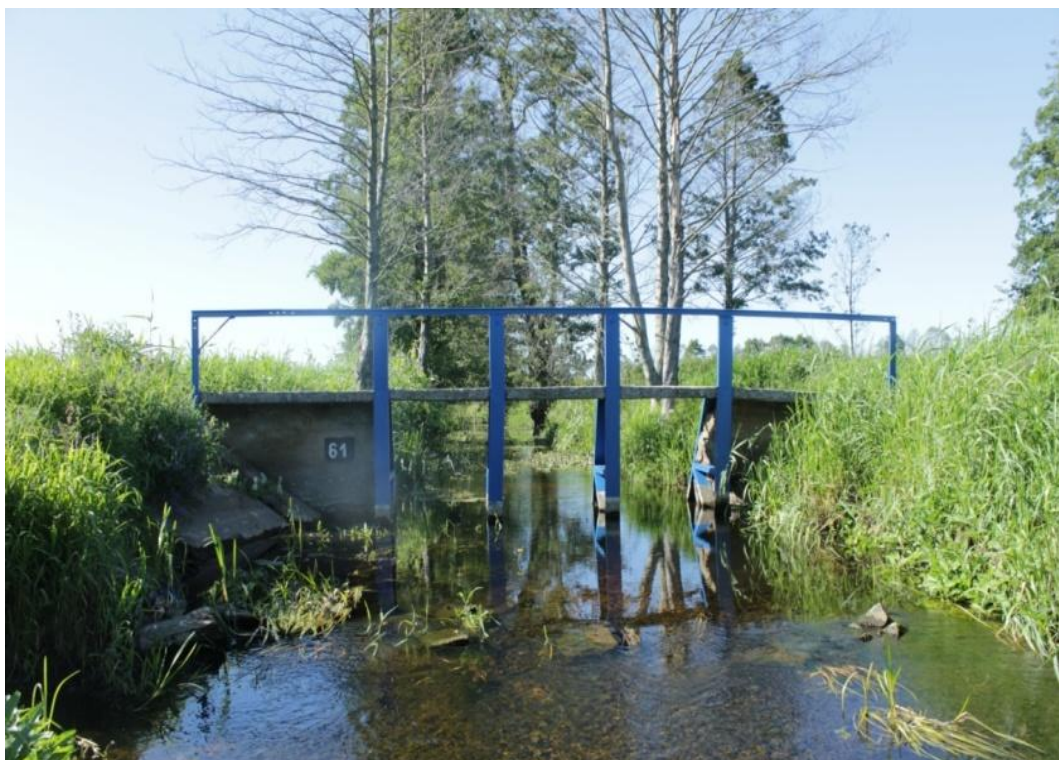
Fot. 6. Odcinek poniżej jazu piętrzącego nr 61 na Flincie
