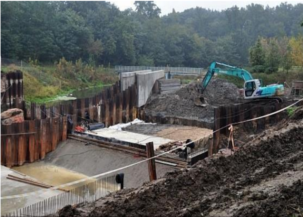
Fot. 2. Budowa jazu głównego (na pierwszym planie wylot wody dolnej)
