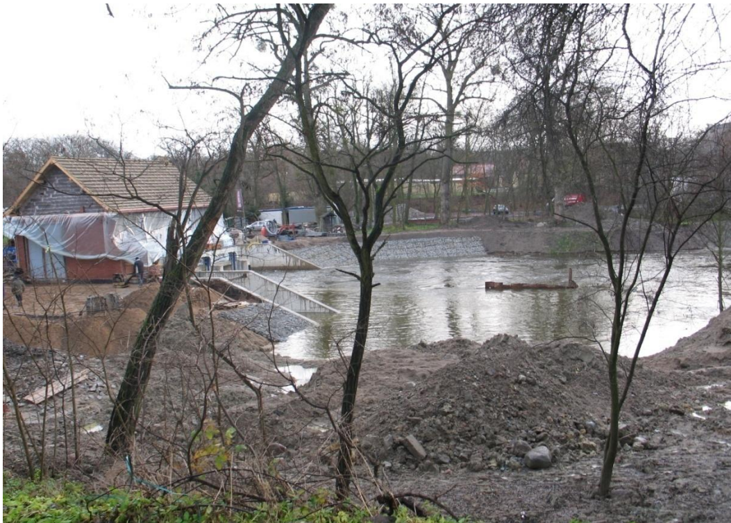
Fot. 12. Umacnianie brzegu rzeki poniżej jazu
