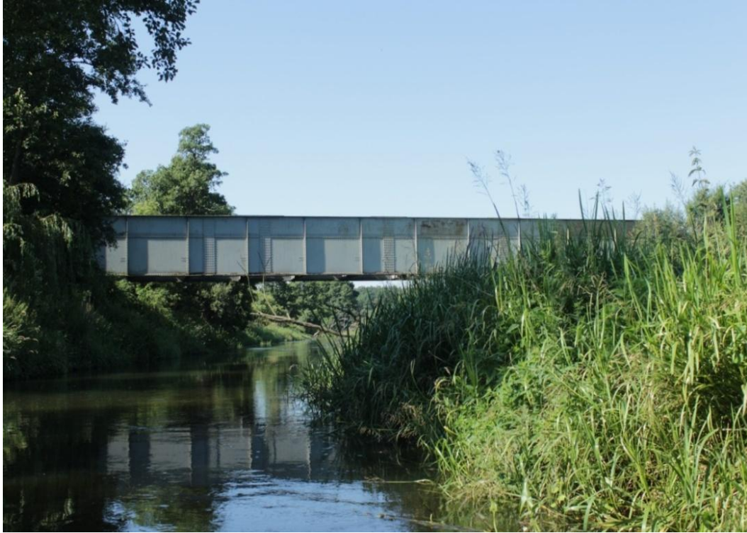
Fot. 25. Most kolejowy w m. Żołędzin
