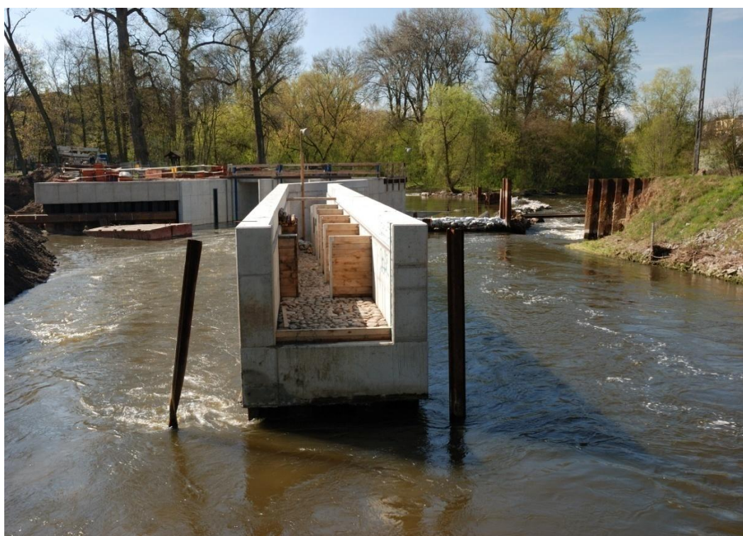
Fot. 4. Przeławka dla ryb (dno wyłożone kamieniami)
