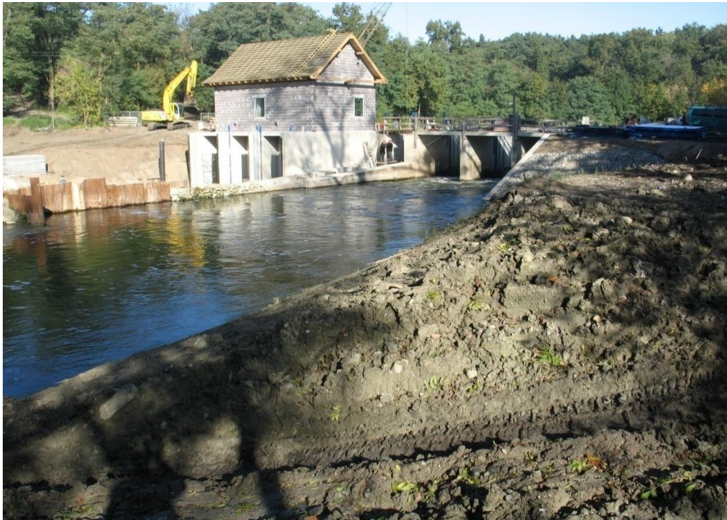
Fot. 11. Widok elektrowni wodnej od strony wody dolnej z lewego brzeg rzeki Wełny
