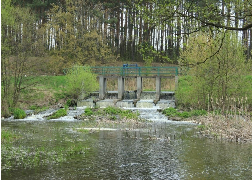
Fot. 17. Jaz żelbetowy, 5 przęśłowy w m. Jaracz
