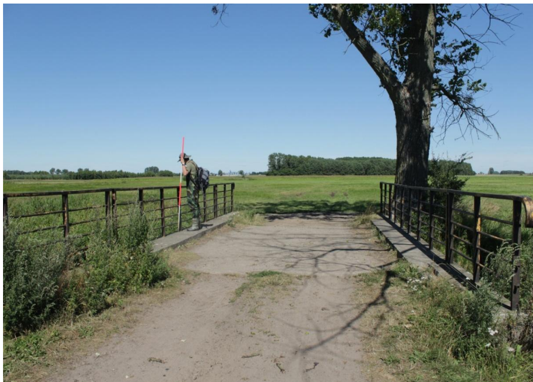
Fot. 5. Most drogowy na Flincie za m. Ryczywół
