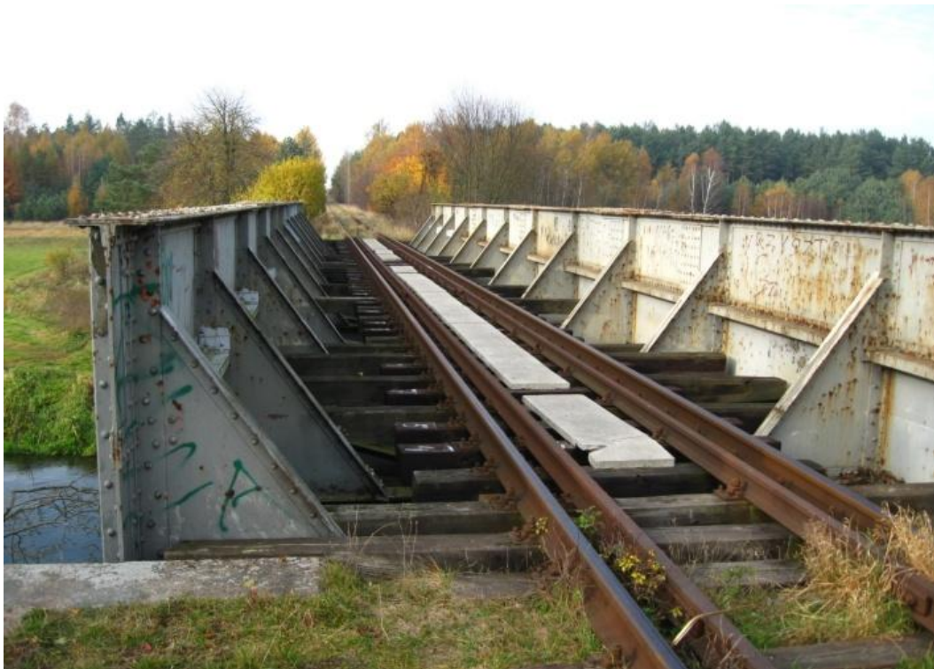
Fot. 26. Most kolejowy w m. Żołędzin
