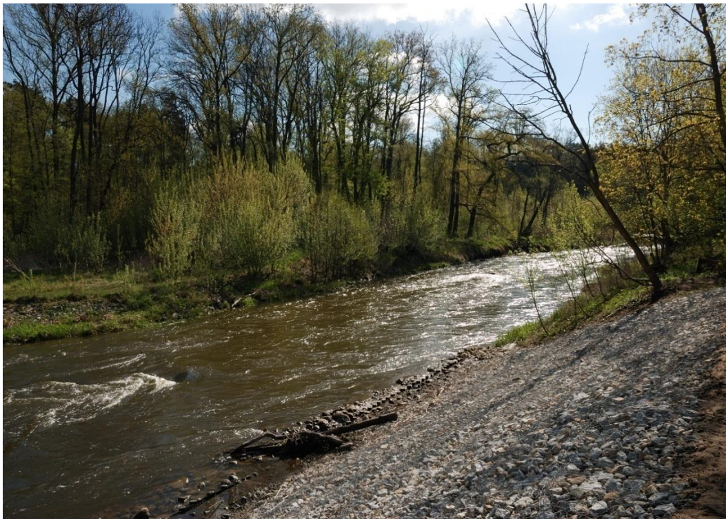
Fot. 8. Umocnienie lewego brzegu rzeki Wełny powyżej stopnia wodnego
