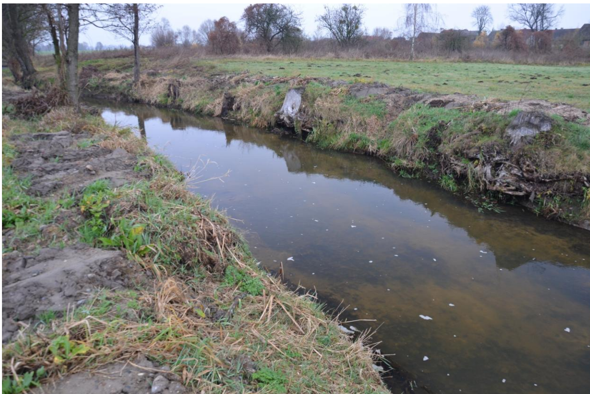
Fot. 11. Efekty prac melioracyjnych na odcinku Flinta-Wiardunki przeprowadzonych w październiku 2013 roku
