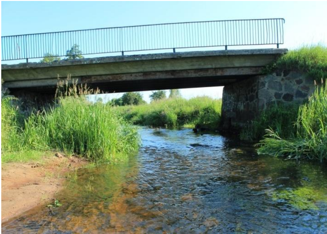
Fot.3. Most drogowy na Flincie w m. Wiardunki
