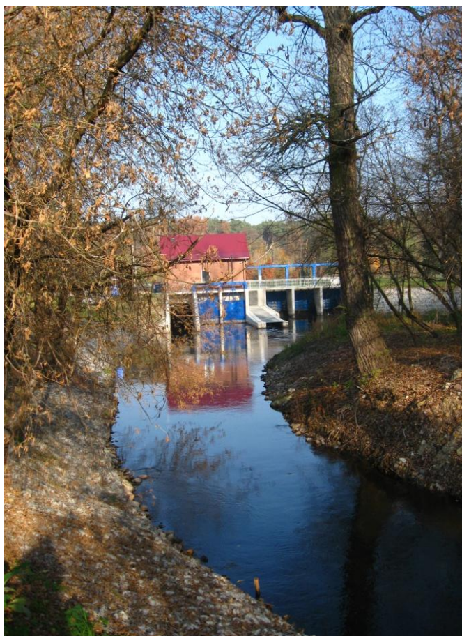
Fot. 2. Odcinek badawczy RHS na Wełnie poniżej MEW Oborniki
