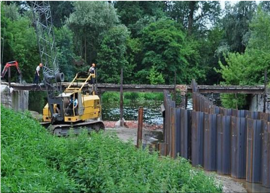
Fot. 1. Budowa szalowania przepławki dla ryb (w tle zniszczona konstrukcja dawnego jazu)
