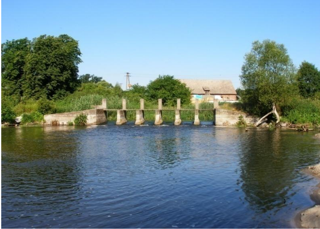
Fot. 15. Jaz żelbetowy, 6-przęsłowy w m. Nowy Młyn
