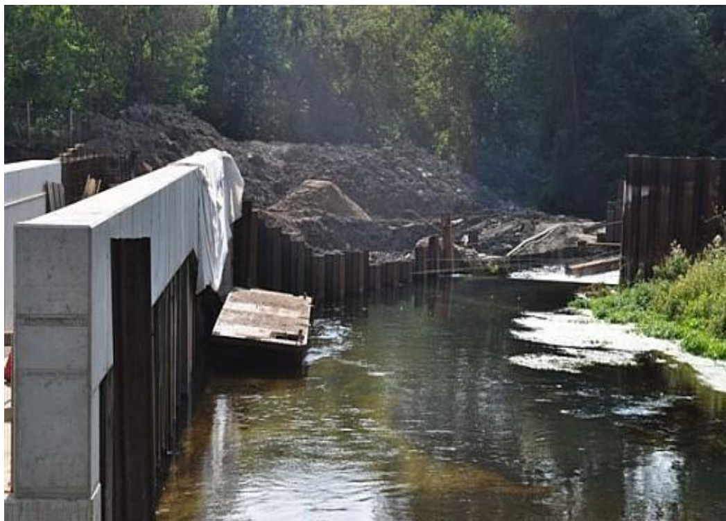
Fot. 3. Budowa przęsła ujęcia wody do elektrowni
