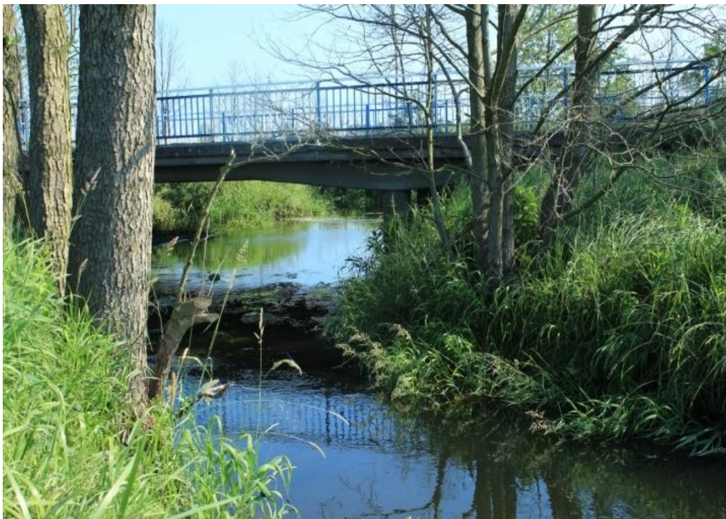
Fot. 4. Most drogowy na Flincie za m. Ryczywół
