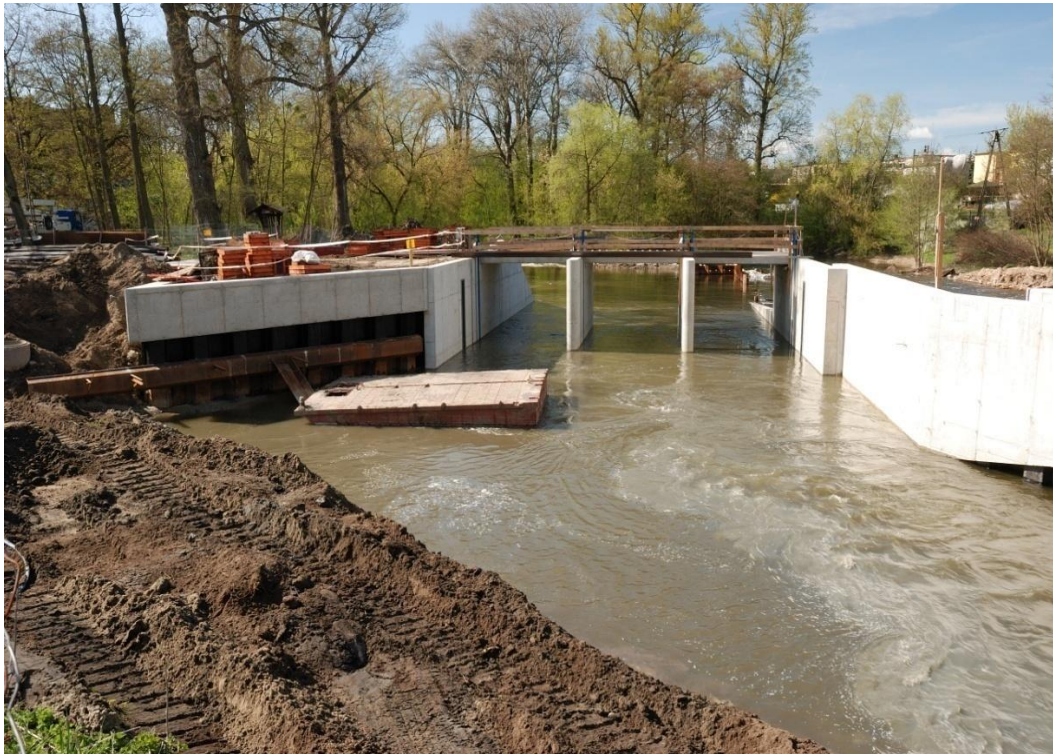
Fot. 5. Jaz główny, widok na od strony wody górnej
