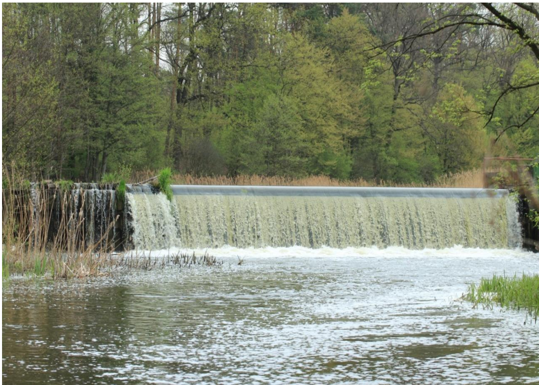
Fot. 18. Próg piętrzący wodę na potrzeby MEW w Jaraczu
