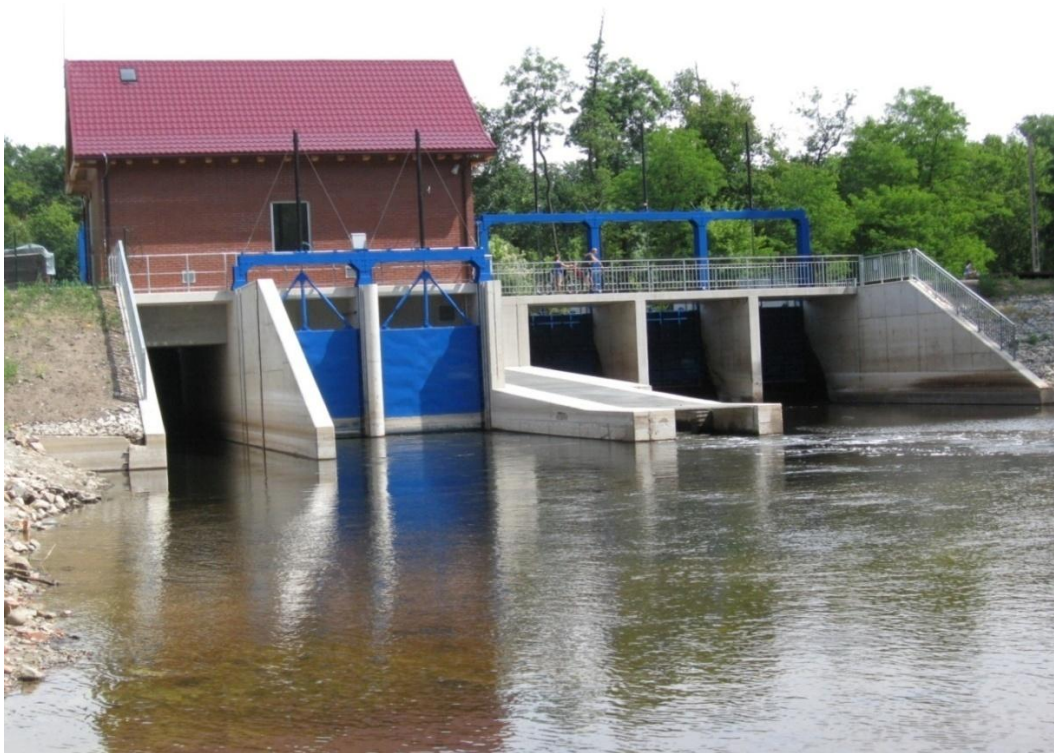
Fot. 14. MEW Oborniki, widok od strony wody dolnej
