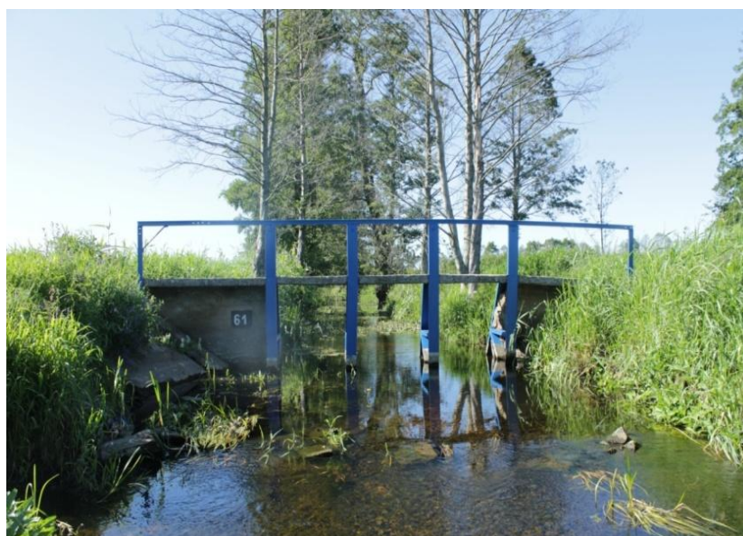
Fot. 6. Odcinek poniżej jazu piętrzącego na Fliencie
