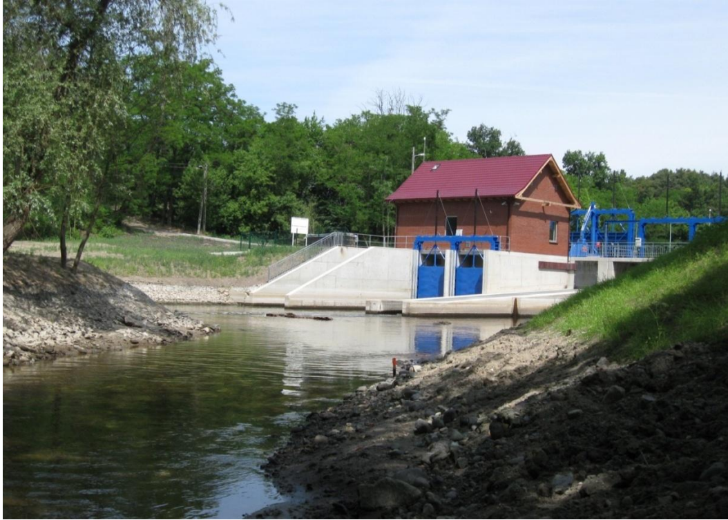
Fot. 13. MEW Oborniki, widok od strony wody dolnej
