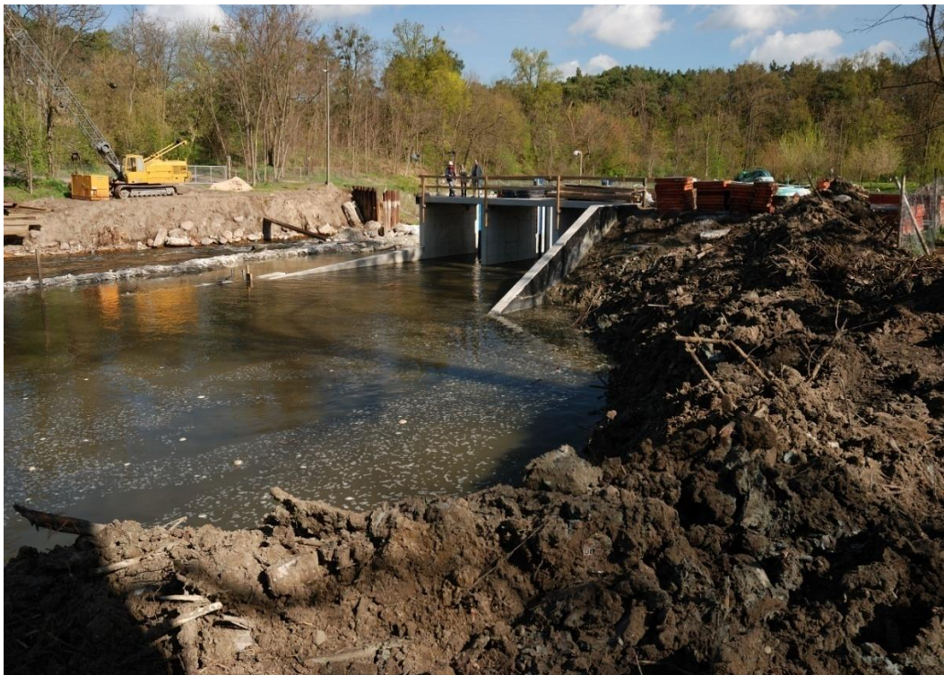
Fot. 6. Wylot wody dolnej, widok z lewego brzegu rzeki Wełny
