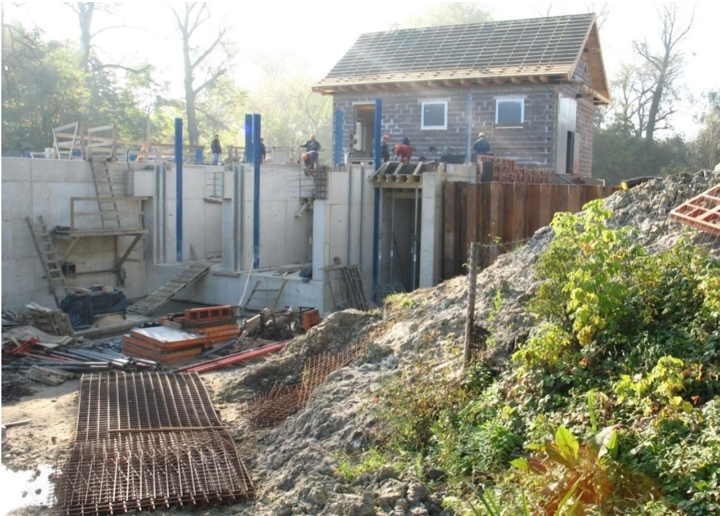
Fot. 9. Budynek elektrowni wodnej (z lewej ujęcie wody do turbin)
