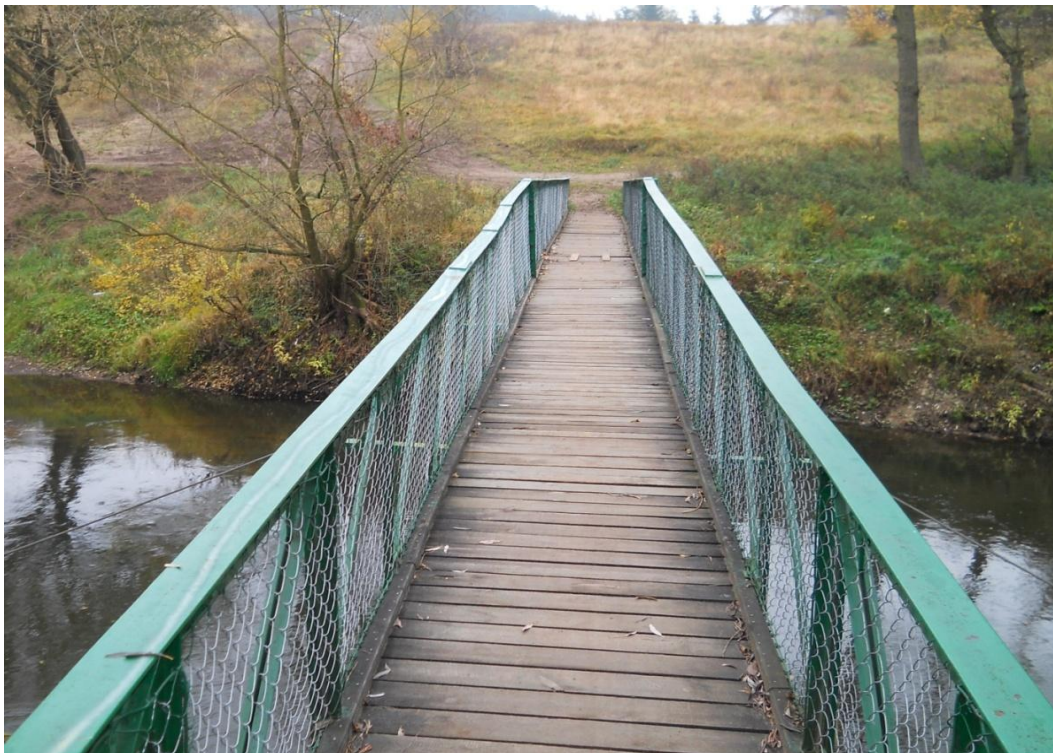
Fot. 22. Kładka dla pieszych w m. Kowanówko
