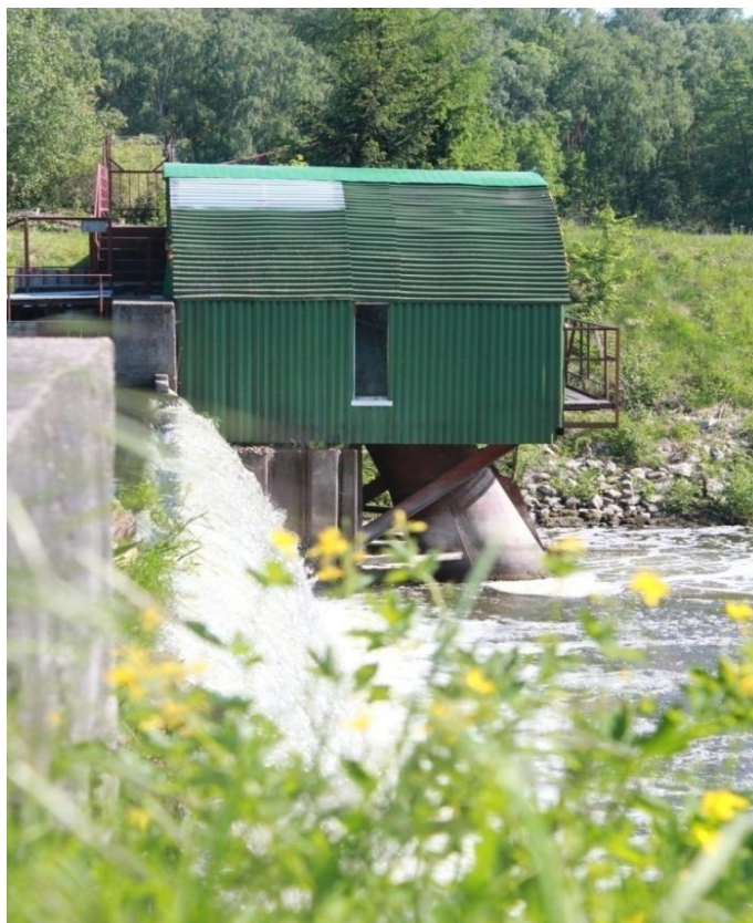
Fot. 19. MEW w Jaraczu, widok od strony wody dolnej
