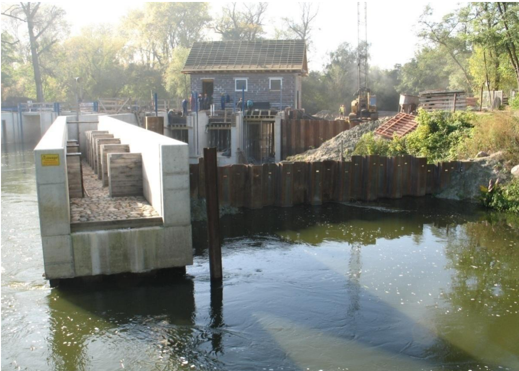
Fot. 10. Przegroda przed ujęciem wody do elektrowni, na czas prac budowlanych
