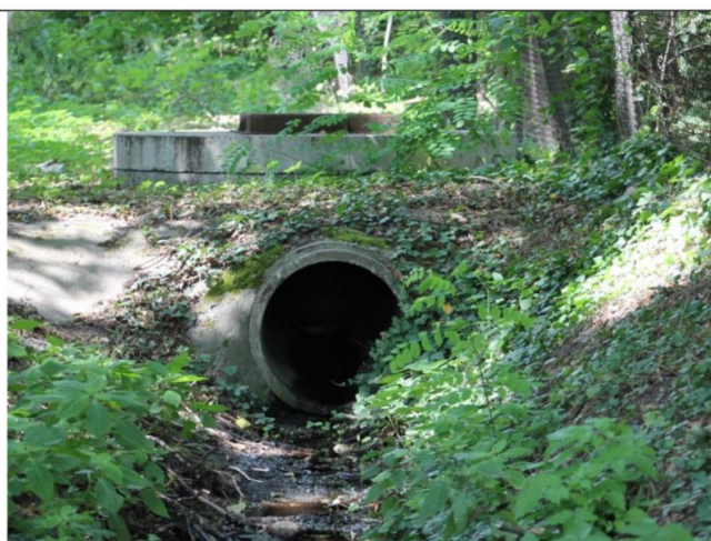
Ujście separatora do Jeziora Rogoźno 03.08.2019r. SJR prosi o udostępnienie pozwoleń wodnoprawnych na odprowadzanie wód opadowych z ulic i placów do Jeziora Rogoźno a także dokumentacji eksploatacyjnej potwierdzającej dotychczasowe inspekcje i czyszczenie separatorów.
