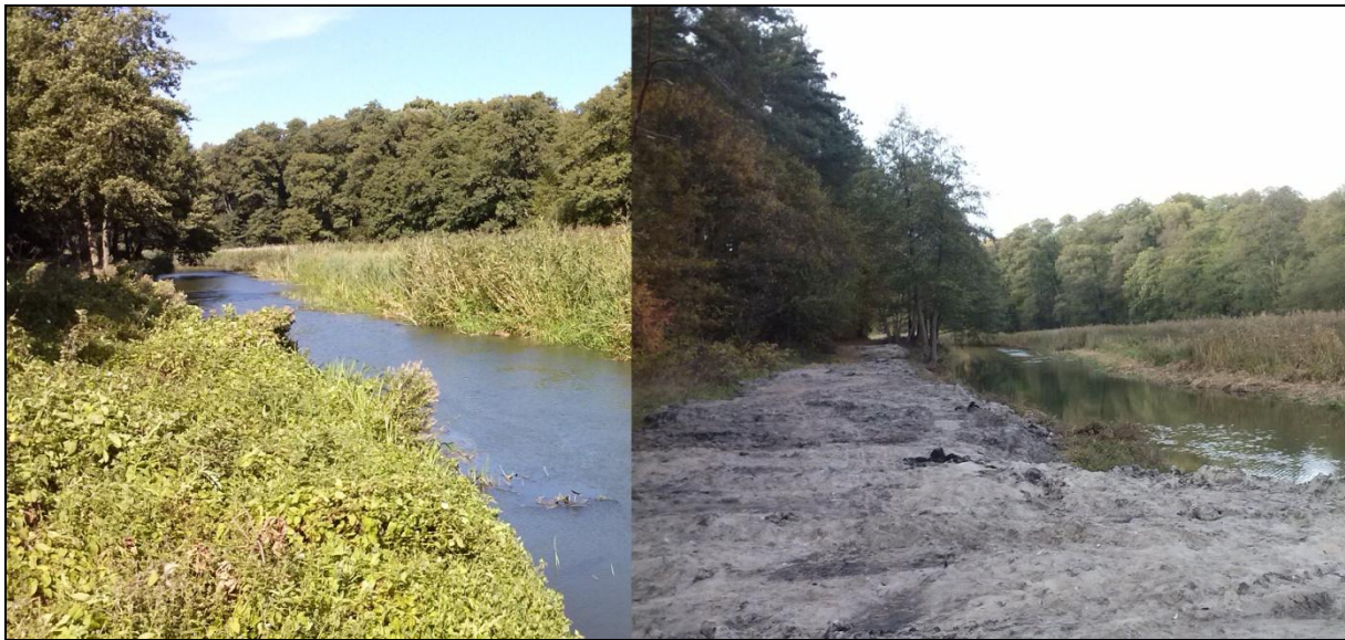
Ryc. 7. Porównanie stanu pobrzeża rzeki Wełny na stanowisku 3 przed (zdjęcie lewe) i po pracach melioracyjnych (zdjęcie prawe) we wrześniu 2013 roku
