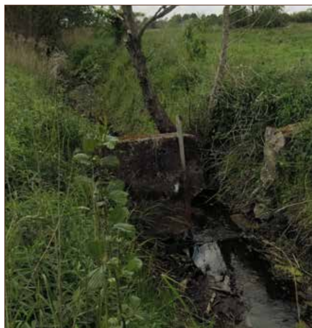
Rycina 4. Przykład zniszczonych zastawek na rowach melioracyjnych
