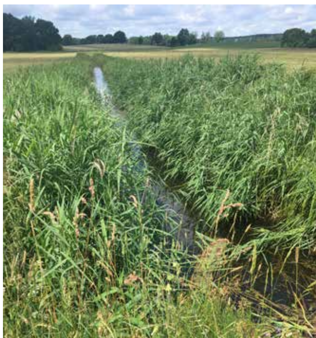
Rów drenująco-nawadniający. Fot. Maria Staniszevska
