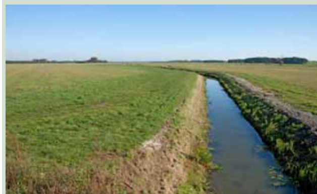
Row melioracyjny bez pasa roślin zielonych i drzewiastych to zła praktyka – woda ulega zanieczyszczeniu, brzeg – rozdeptywaniu przez pasące się zwierzęta, dochodzą też straty wody przez wzmożone parowanie oraz niewykorzystanie potencjalnego szlaku migracyjnego dla dziko żyjących gatunków (fot. KK)
