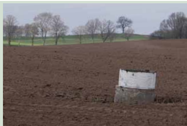
Nie należy sadzić drzew w bezpośrednim sąsiedztwie urządzeń melioracyjnych, aby uniknąć ich zapychania przez korzenie poszukujące dobrze natlenionej wody (fot. JZ)
