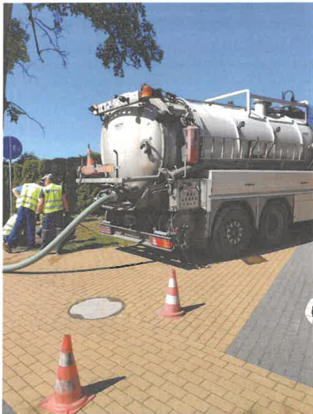
03.06.2020 r. - Czyszczenie separatorów w Gminie Rogoźno
