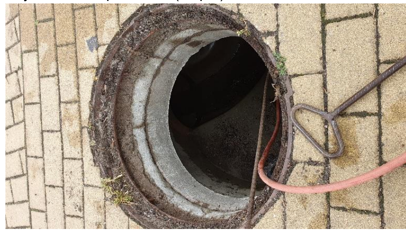
Czyszczenie separatorów (etap 1) 08.07.2021
