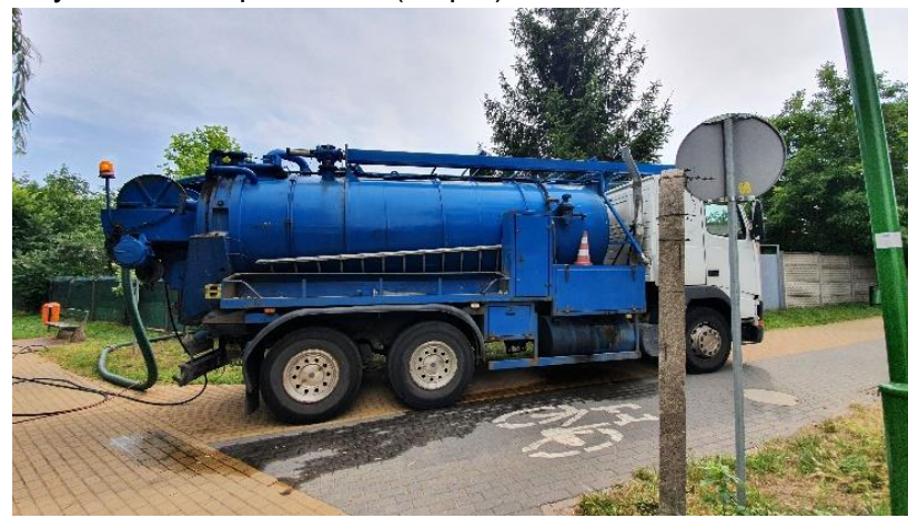
Czyszczenie separatorów (etap 2) 12.07.2021
